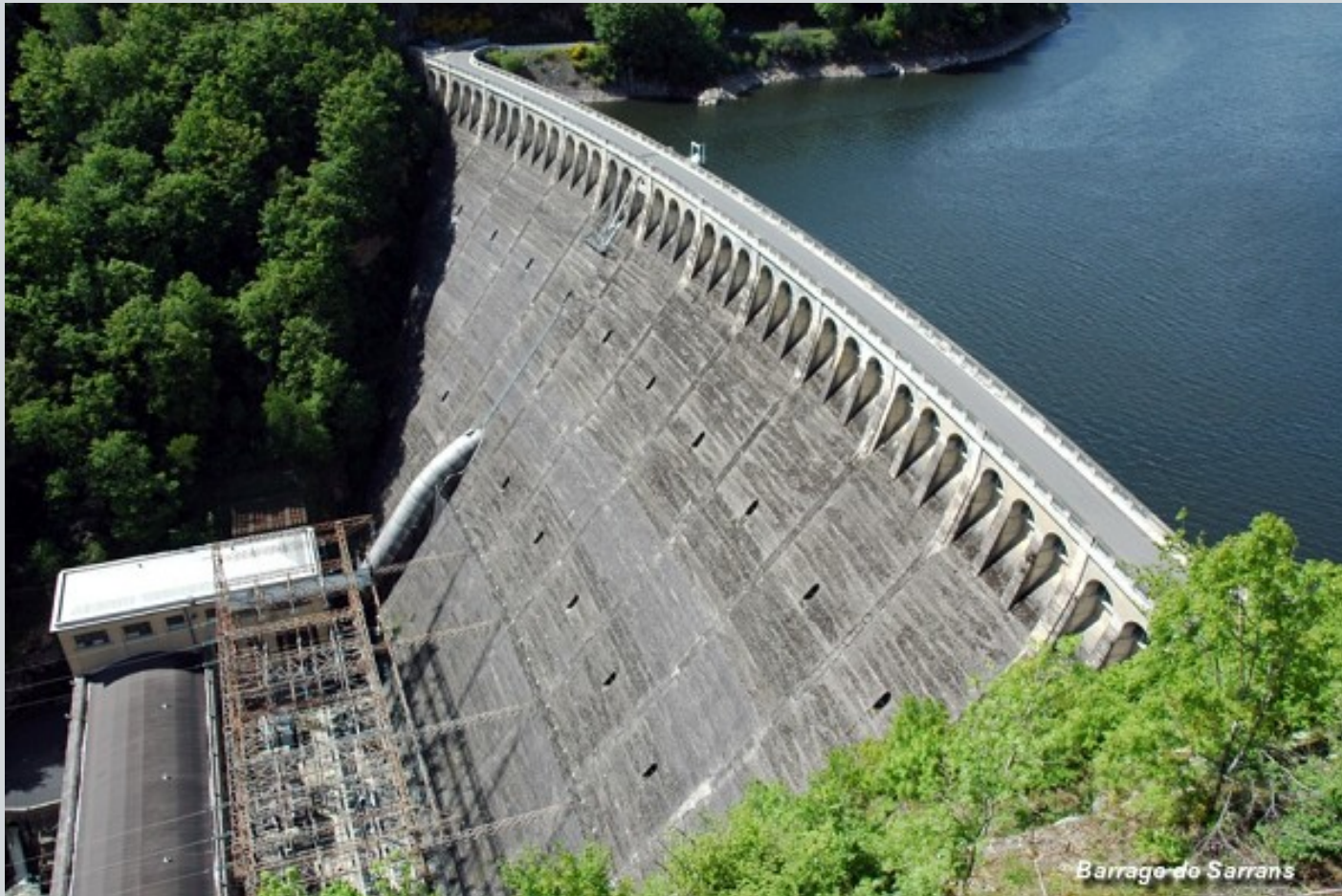
Barrage poids en béton de Sarrans, France ( http://structurae.info/ )
