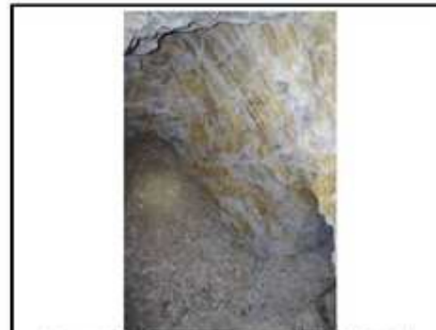
Photographie L-11 : Faille délimitant la montée de voûte MV96 (Photo 3030)
