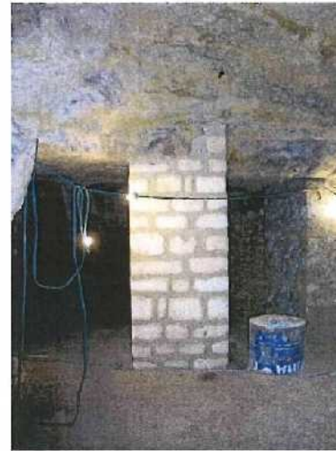
Masse en ciel après construction du pilier
