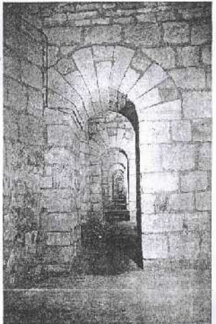
Une vue intérieure de la citadelle.
