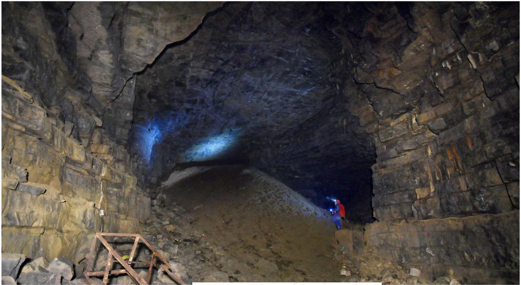
Photo N° 18: Vue d'ensemble du toit de la salle 3 à partir du bas
