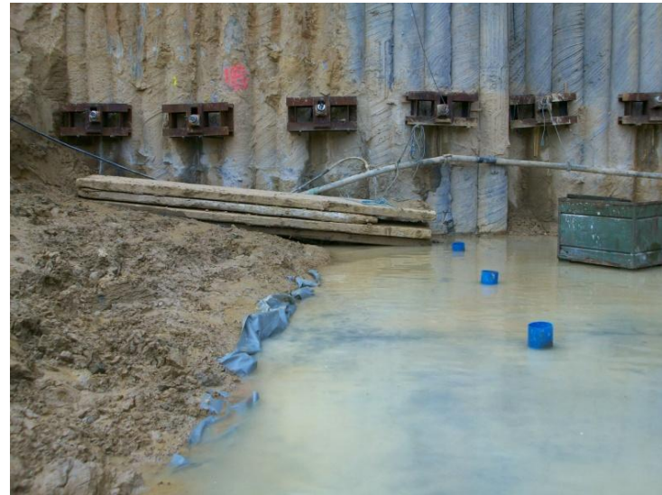
Mise en tension et 3 ème déblais
