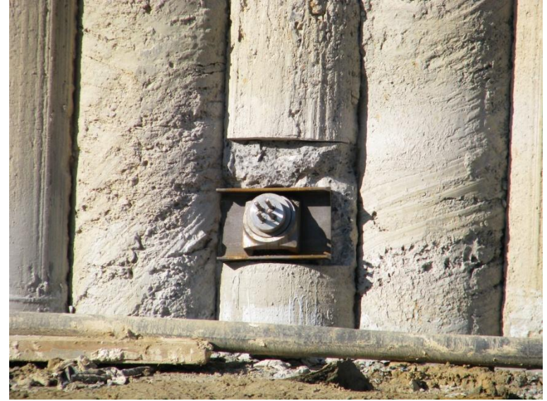
mise en tension
