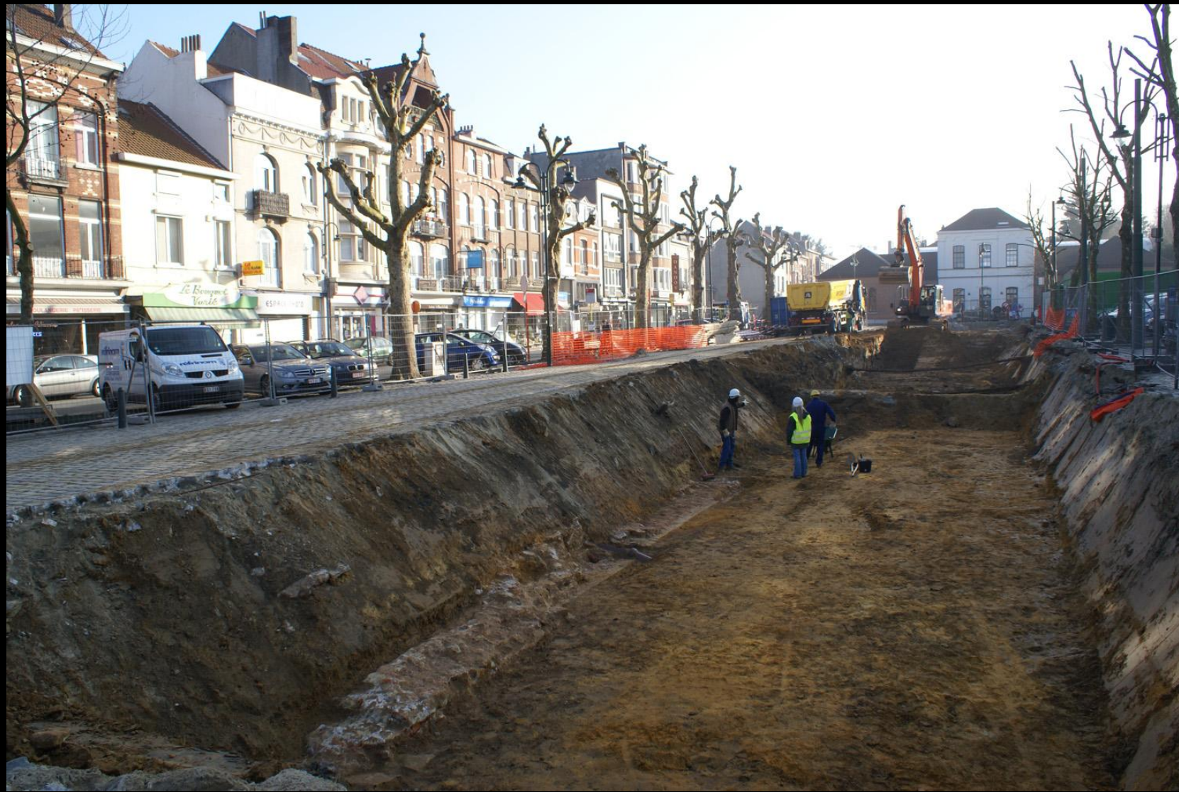
Bassin d'Orage, St.-Job, Uccle
