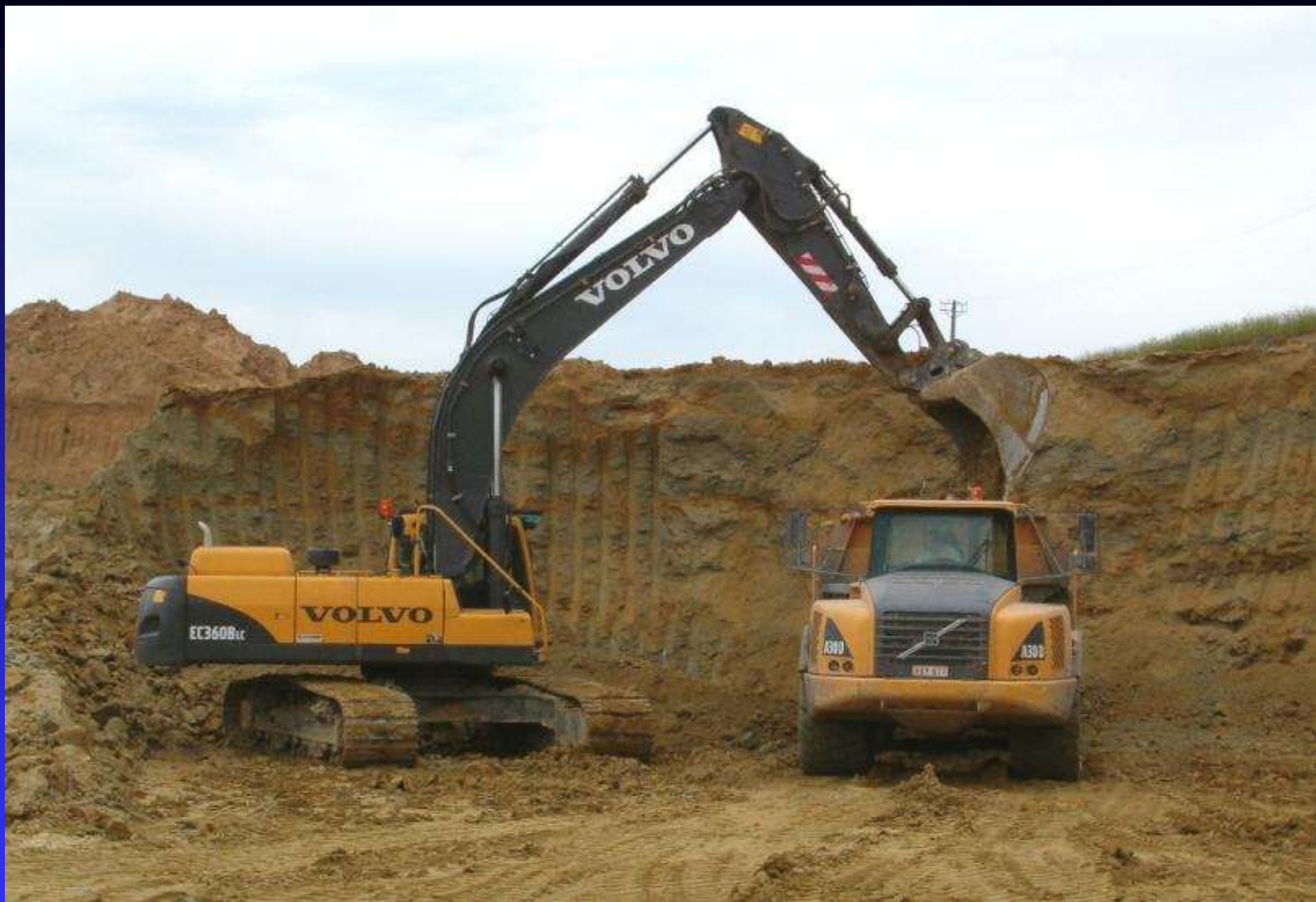
Pelle en rétro de 48T (3m 3 ) chargeant un dumper articulé de 35 T
