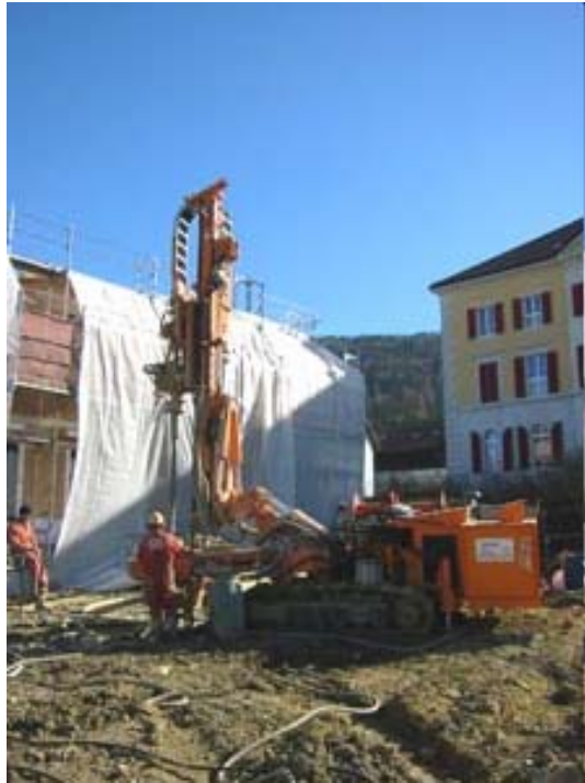
Chantier de forage
