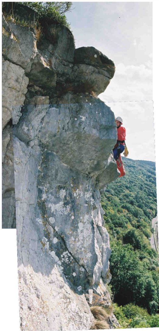
A1-37 - Compartiment C23 Détail de la fracturation arrière
