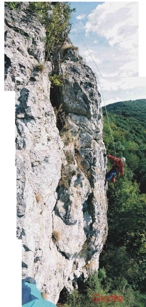
A1-40 - Compartiment C24 Détail de la fracturation arrière côté Nord
