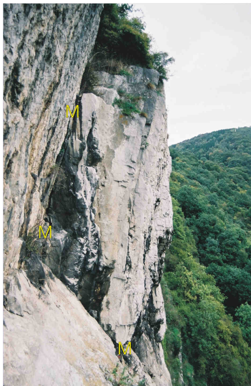
A1-4 - Compartiment C1 Vue latérale de la masse principale. Implantation des repères de contrôle
