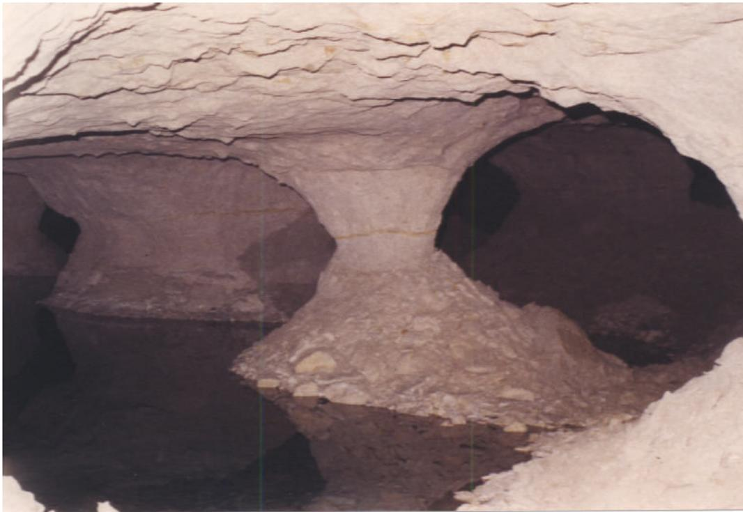
Exemple de pilier écaillé dans les carrières souterraines de la Malogne.
