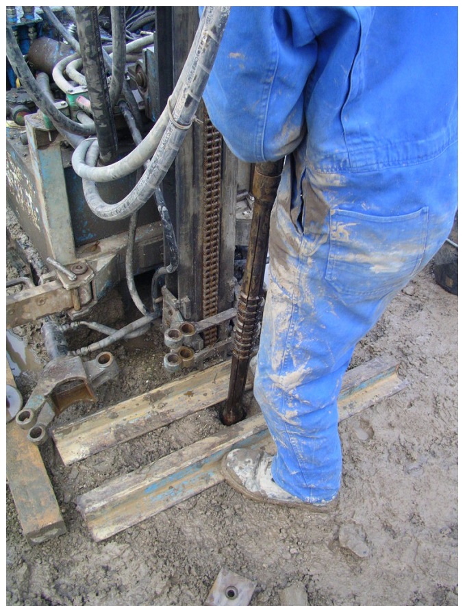
4) Mise en place de la sonde picométrique
