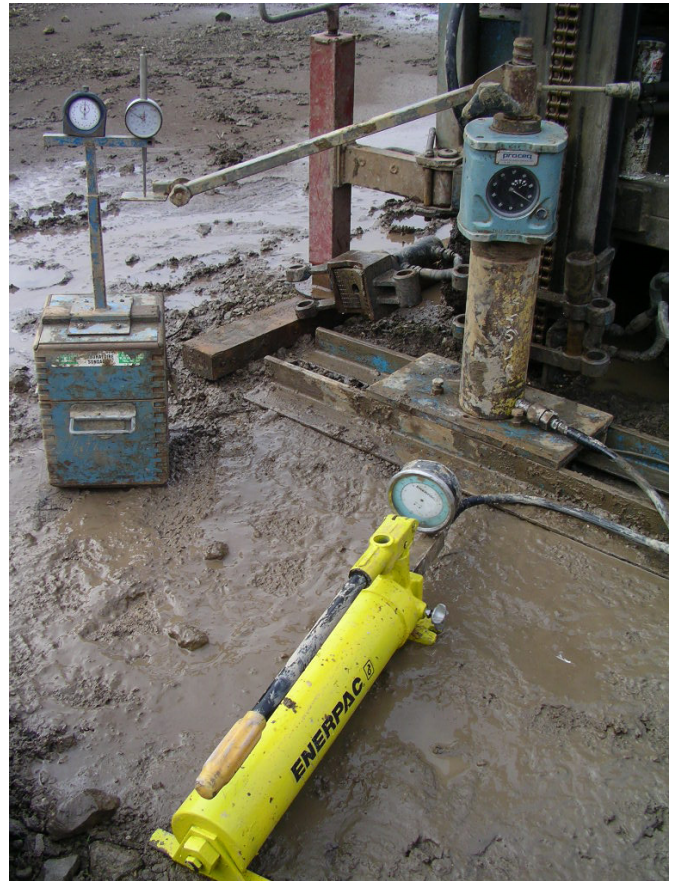
8) Dispositifs de mise en traction et de mesure de déplacements verticaux mis en place
