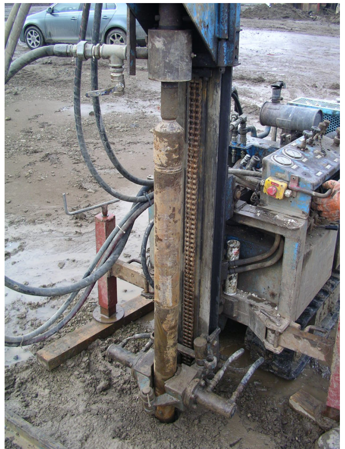
2) Mise en place du tubage
