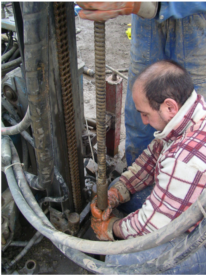
5) Mise en place des tiges de traction
