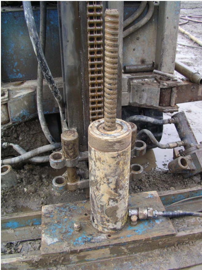
7) Mise en place du vérin creux
