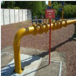
Captage sur puits de mine ou sondage existant
