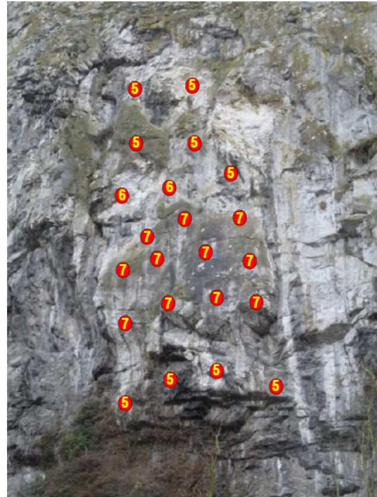
A1- 48 - Ensemble Z25 - Masse de 400 à 500m<sup>3</sup> à stabiliser par ancrage (travaux non prioritaires)
