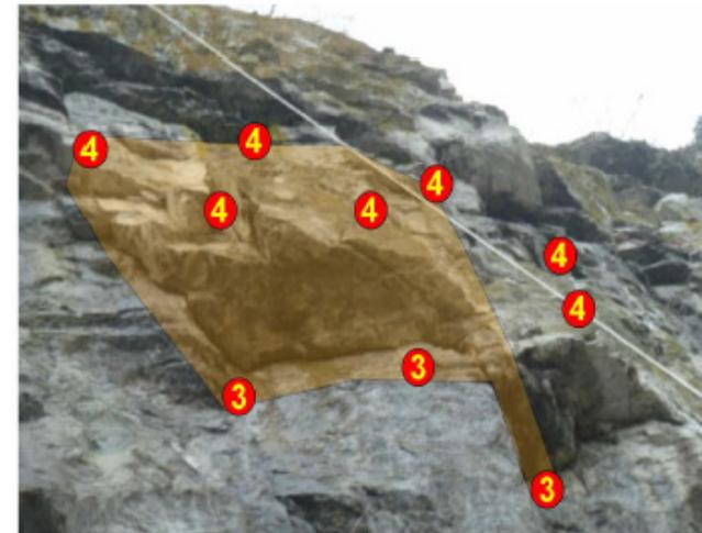
A1- 27 - Ensemble Z13 - Détail de l'écaillage latérale droite à stabiliser par filet métallique plaqué et ancrage.
