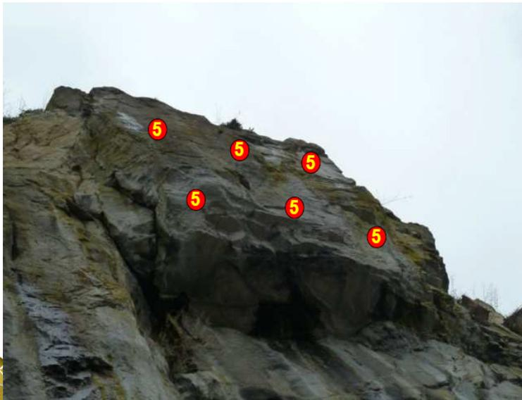
A1-15 - Ensemble Z7 - Masse de 30m3 à stabiliser par ancrage passif
