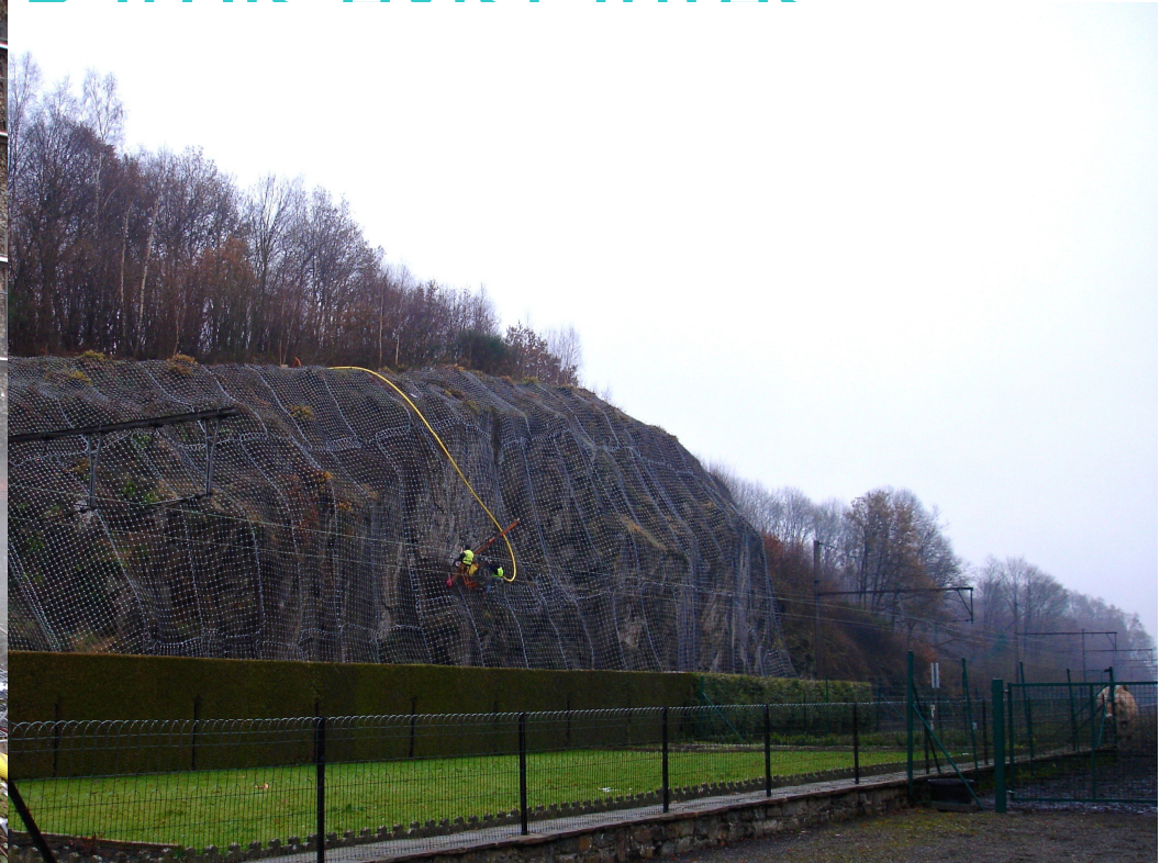
Forage sur corde
