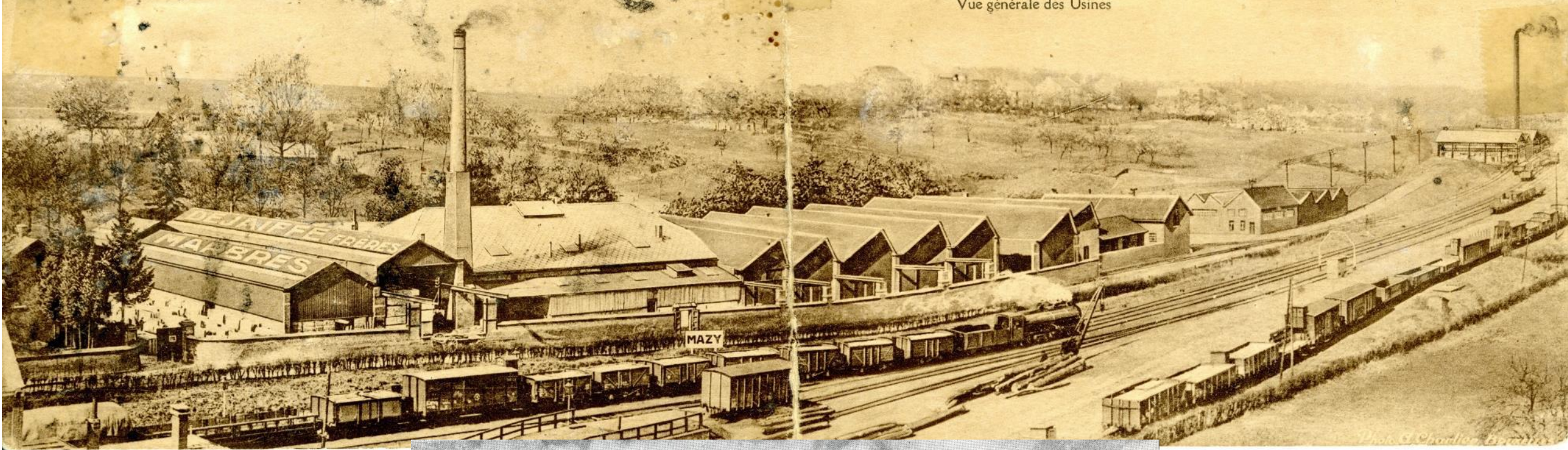
DEJAIFFE Frères, MARBRES, MAZY Vue générale des Usines
