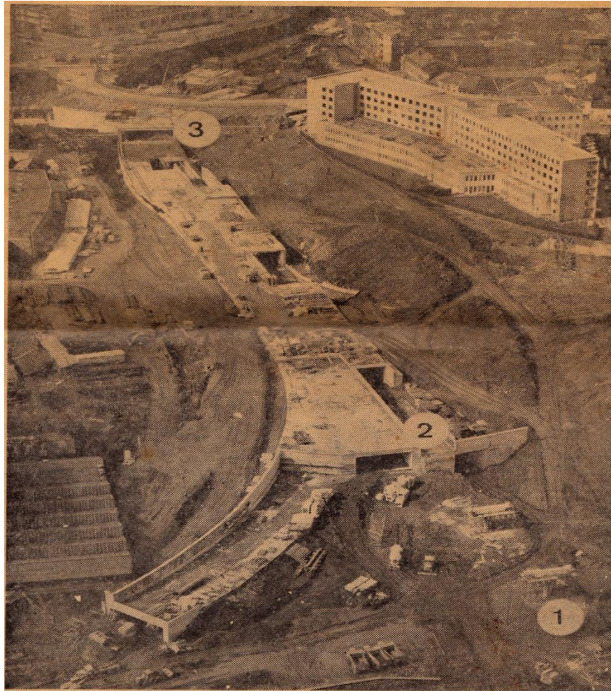
● A hauteur du pont de Waterloo (3), les travaux de déconstruction du semi-métro se greffent en quelque sorte sur ceux du petit ring. En effet, un des trois niveaux des tunnels édifiés en cet endroit est réservé au semi-métro dont l'antenne en direction de Montignies est également en construction. C'est d'ailleurs la première antenne en cours de réalisation (1 et 2).
