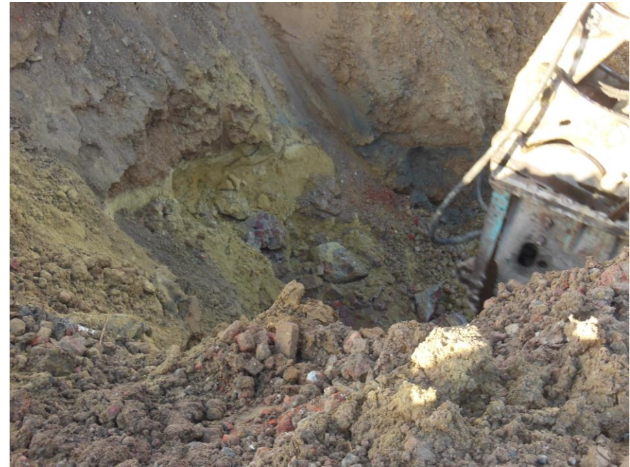
Démolition de concrétions ferrugineuses
