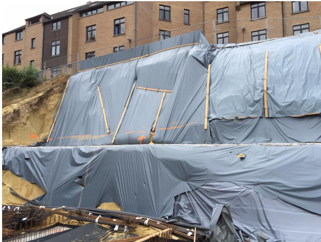
Mise en œuvre sur chantier
