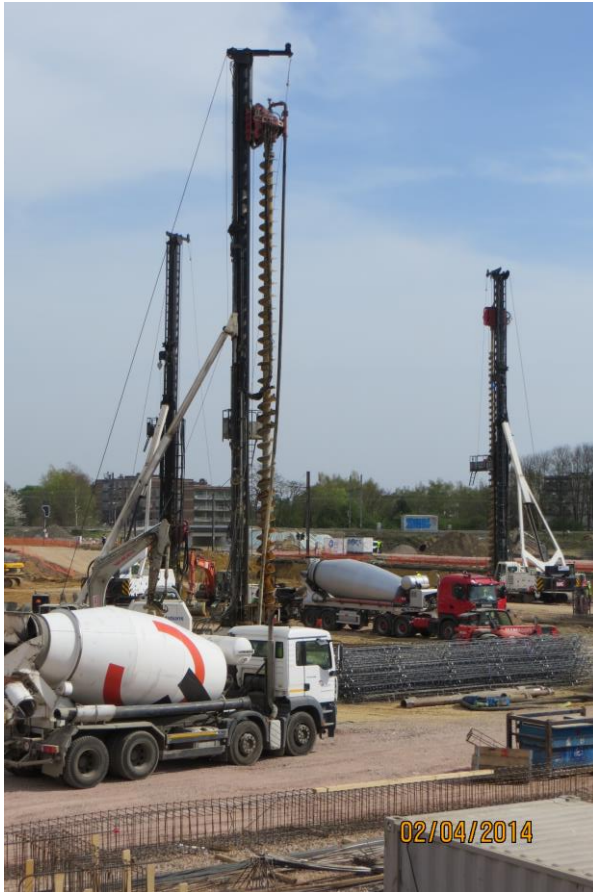
Préforage avant exécution des pieux
