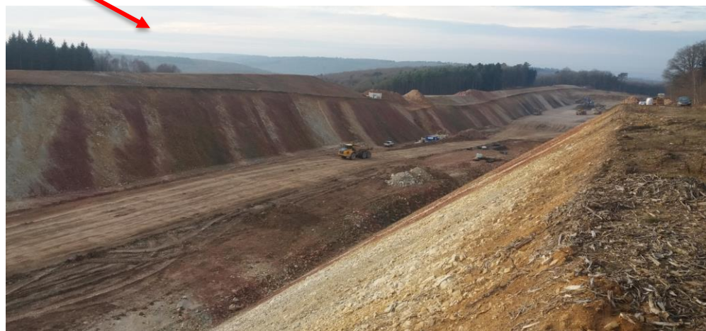
Tranchée de l'Hermitage - D8 – max 33 m
