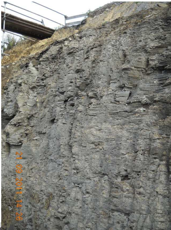
Talus fouille, chantier liaison Esch-Micheville
