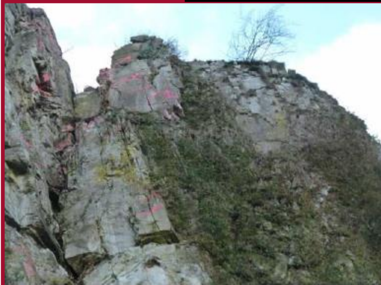
A1-7 - Ensemble Z3 - Exemple de blocs instables jusqu'à 7m 3 . Protection passive par écran pare-blocs en bas de versant
