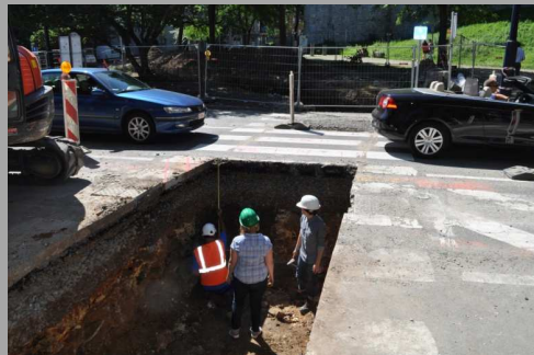
Traversée de la rue Bord de l'Eau
