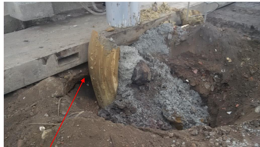
La platine tombe dans une cavité et puis le tube se remplit de terre
