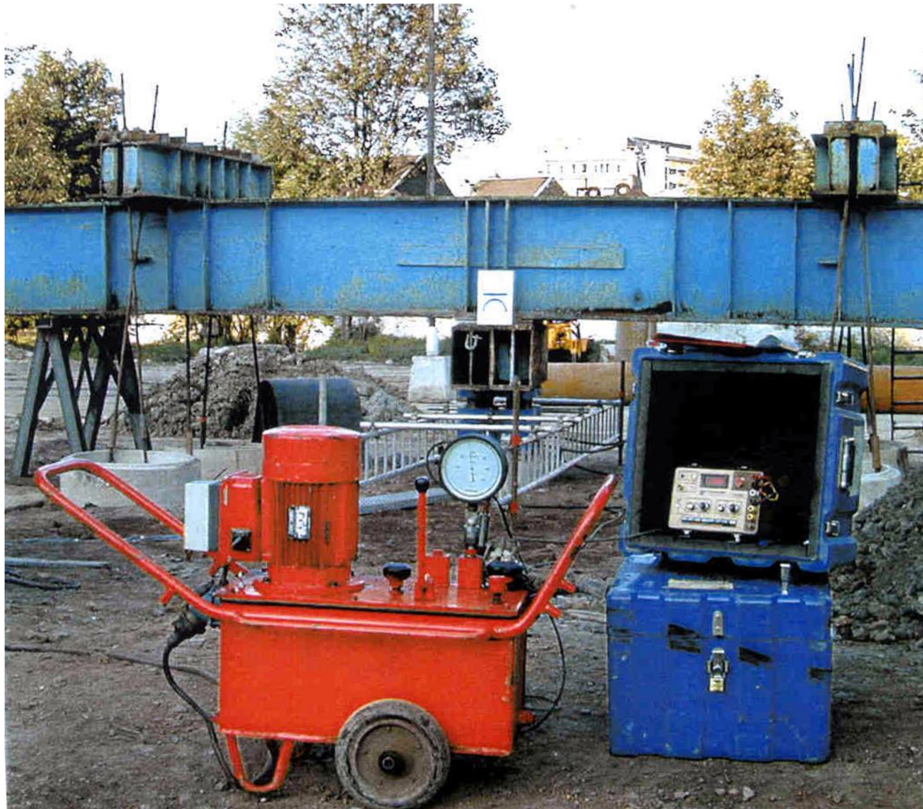
Essai de pieux Chargement du pieu
